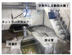
図3 自動採水器設置状況
