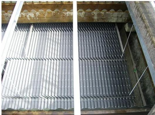
写真-1 傾斜板の設置状況
