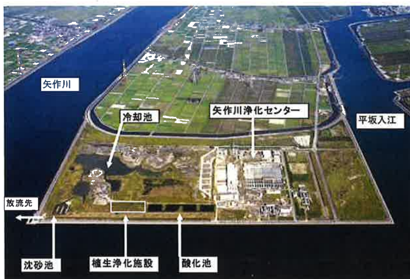
写真 2 矢作川浄化センターと安定化池
