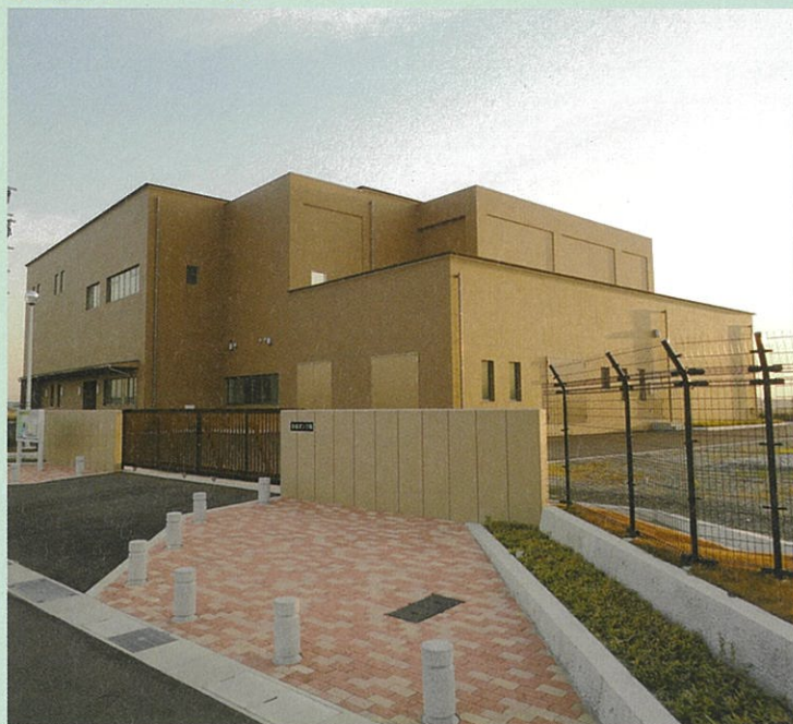
弥富ポンプ場
