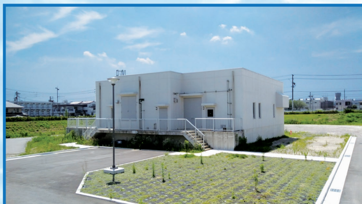
揚水ポンプ棟
