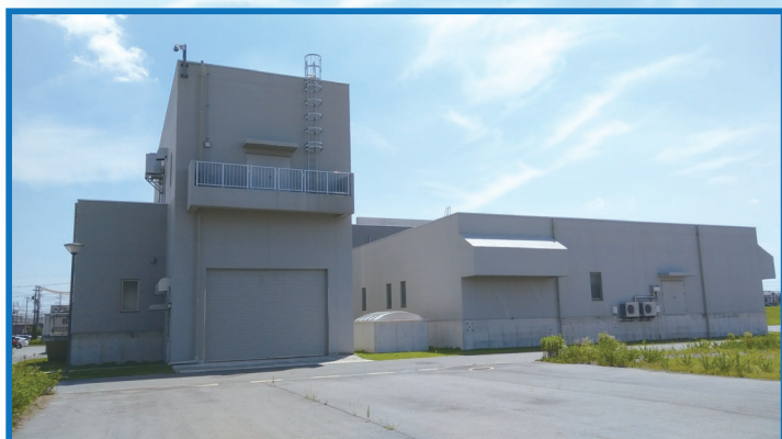
流入ポンプ棟
