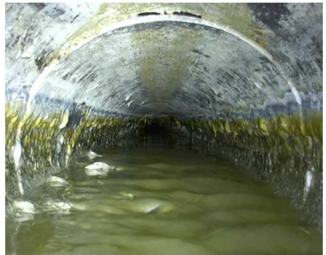
写真-2 管口カメラ内部状況
