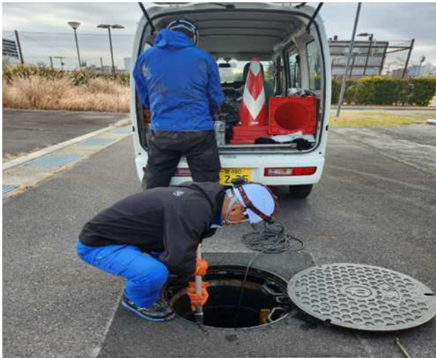
写真-1 管口カメラ調査状況
