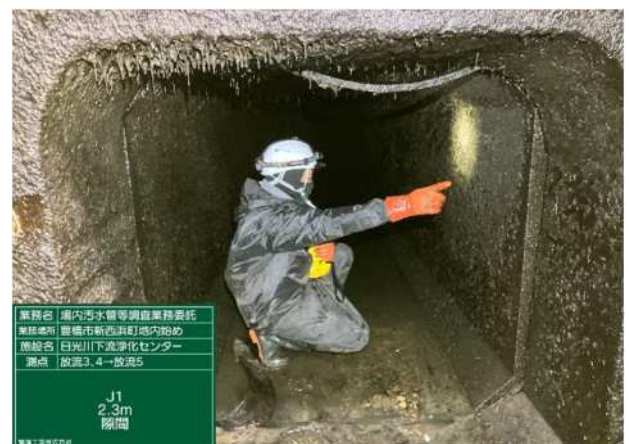
写真-6 放流管渠状況(潜行目視)
