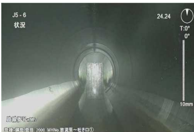
写真-5 放流管渠状況(自走式TVカメラ)
