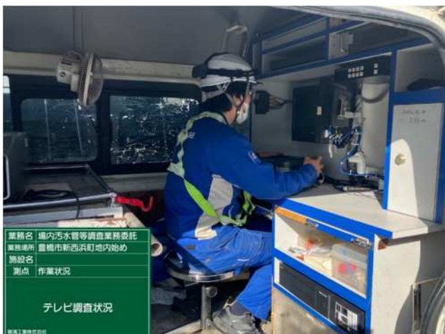
写真-3 自走式TVカメラ調査状況
