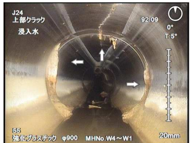
写真-4 自走式TVカメラ内部状況
