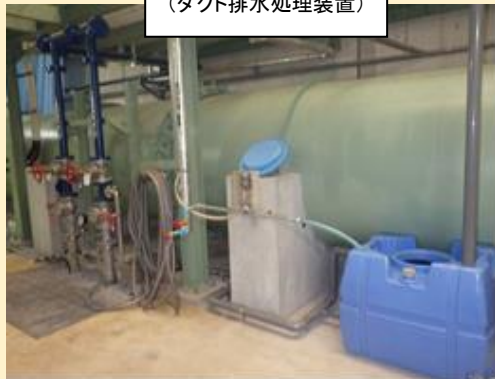
提案の現場採用 (ダクト排水処理装置)
