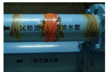
写真-1 孔食によるSGPW管の漏水
