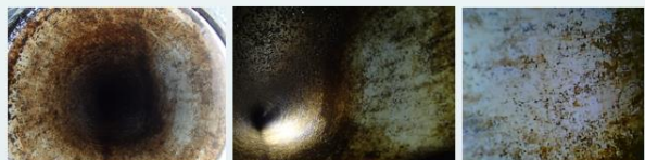
図-6 SGPWから修繕した管の内部状況
