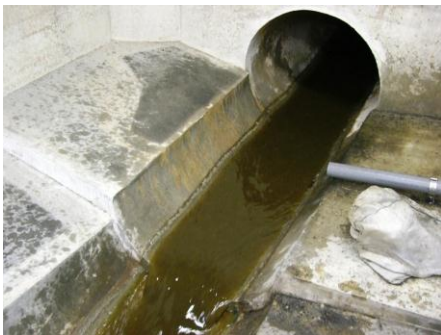
写真-5 基準を超過した排水の様子
