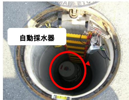
写真-6 自動採水器の設置の様子
