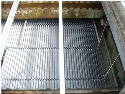
写真-1 傾斜板の設置状況
