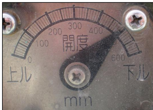
図-4 分配可動堰の既設の開度目盛
