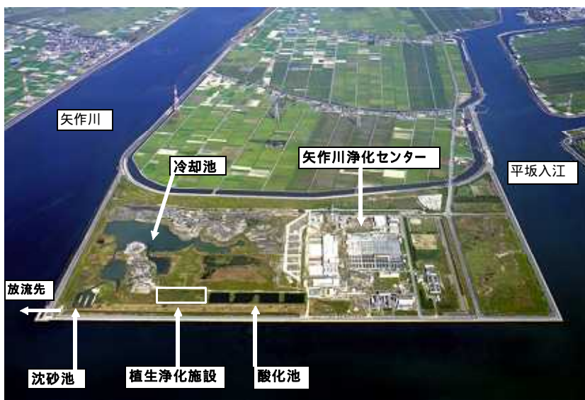
写真2 矢作川浄化センターと安定化池
